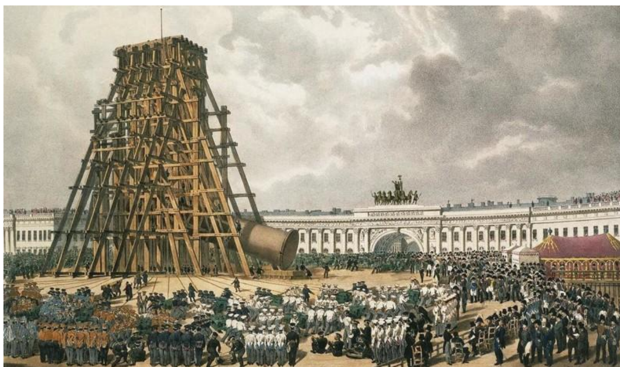
Рисунок 2.2 - Установка Александрийской колонны с помощью механизма Бетанкура
